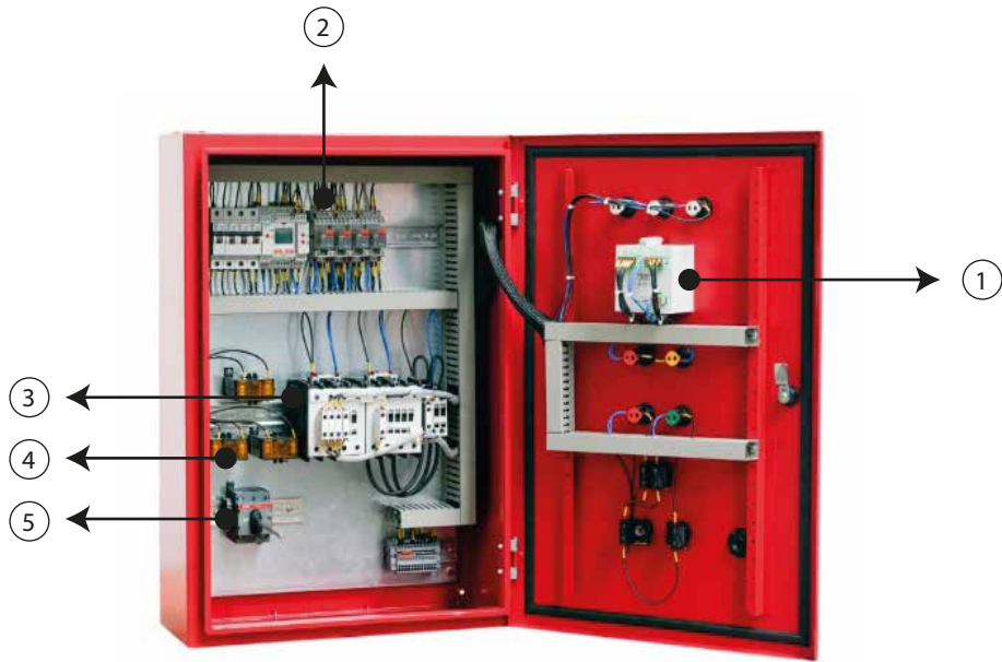
1- Kontrol Paneli, 2- Röleler, 3- Kontaktörler, 4- Akım Trafosu, 5- Ana Şalter
